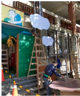
112年進行外部整修
