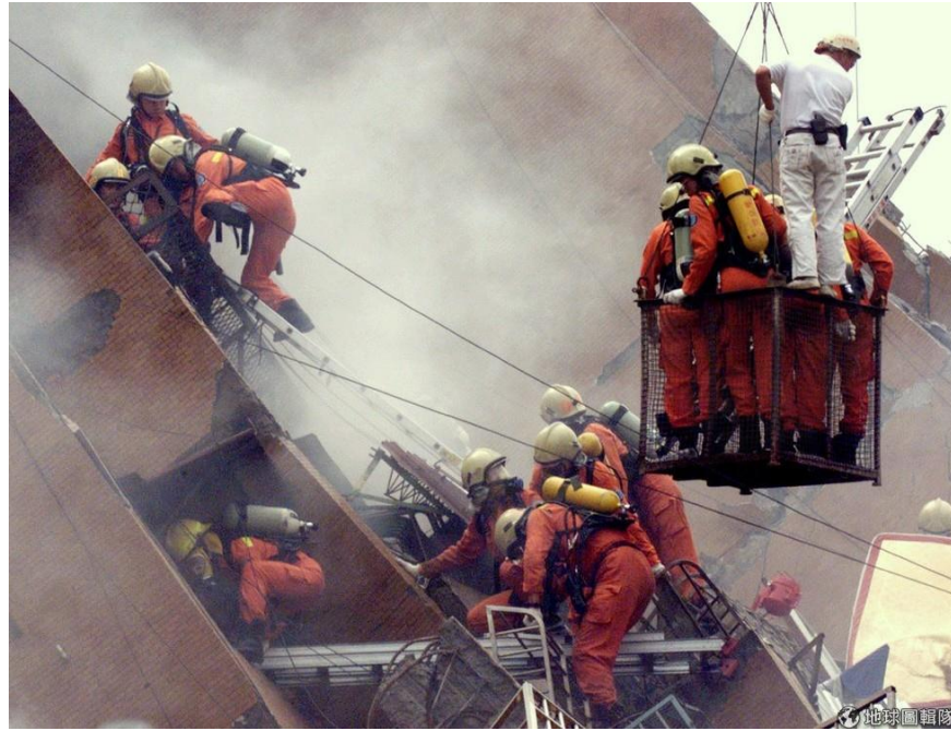
▲救難人員在不斷冒出沙塵的東星大樓外搶救傷患。
