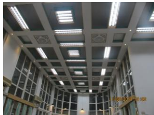
改善天花板照明及通風設備
